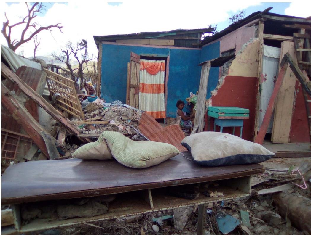
Figure 5: Dégâts à J3 dans le village de Coteaux (Sud)
